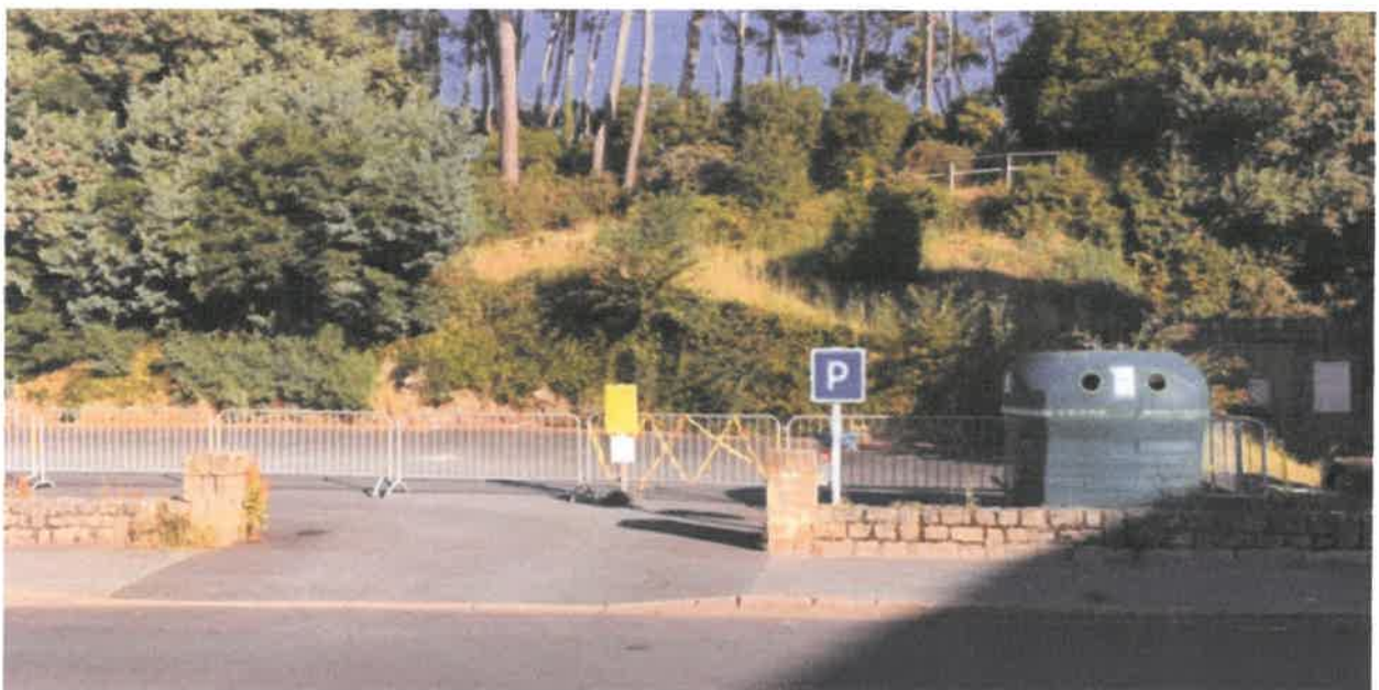
Photo avec le repérage du projet par la pose de barrières
